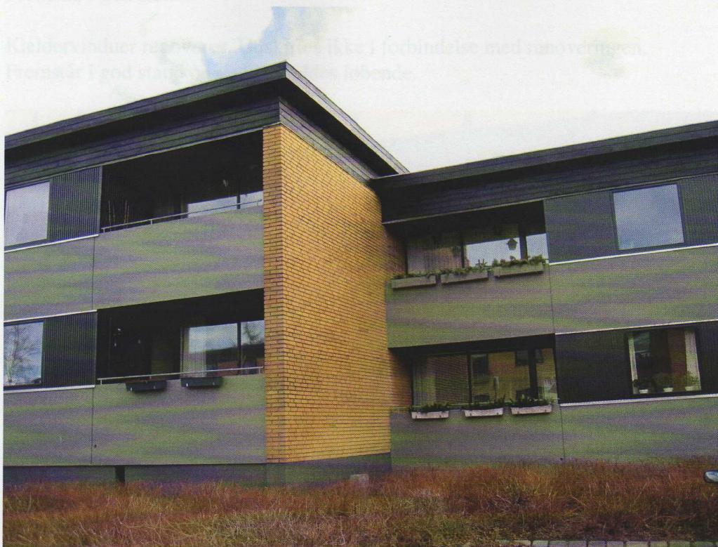
Udsnit af renoveret havefacade
