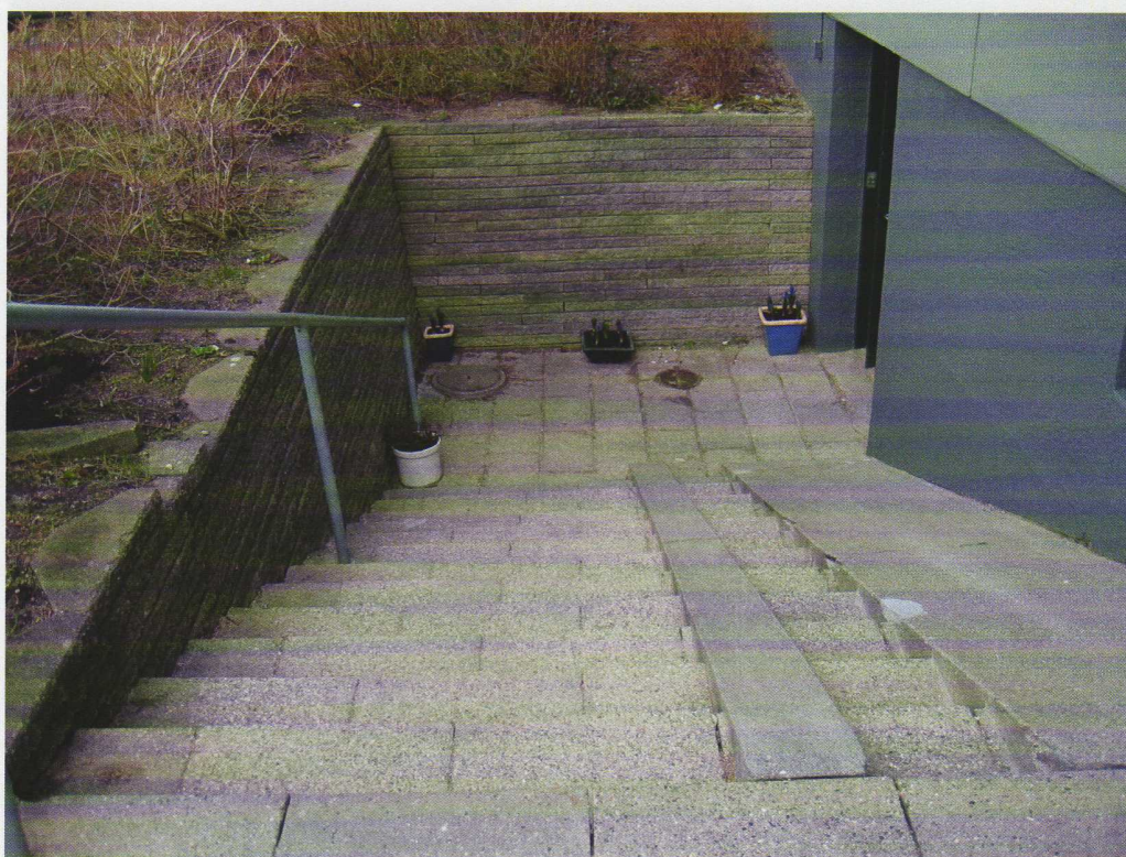
Trappe til kælder
